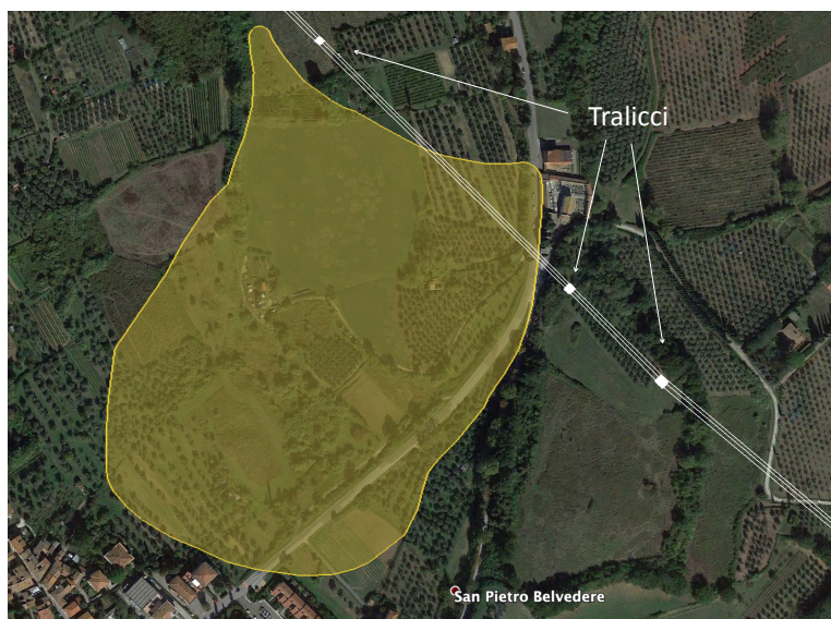
Intersezione tra l'elettrodotto AT e la frana di Santo Pietro
